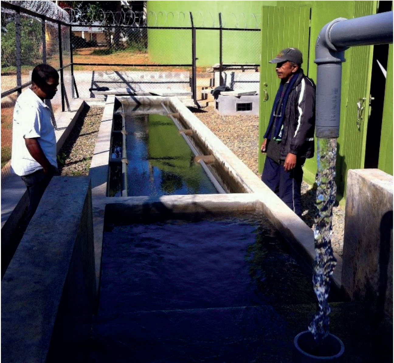
Filtre à sable lent construit par l'entreprise Bushproof à Andemaka (Vatovavy Fitovinany)
