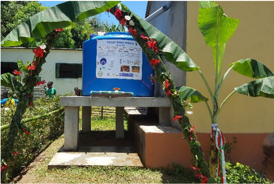
Citerne de récupération d'eau de pluie
