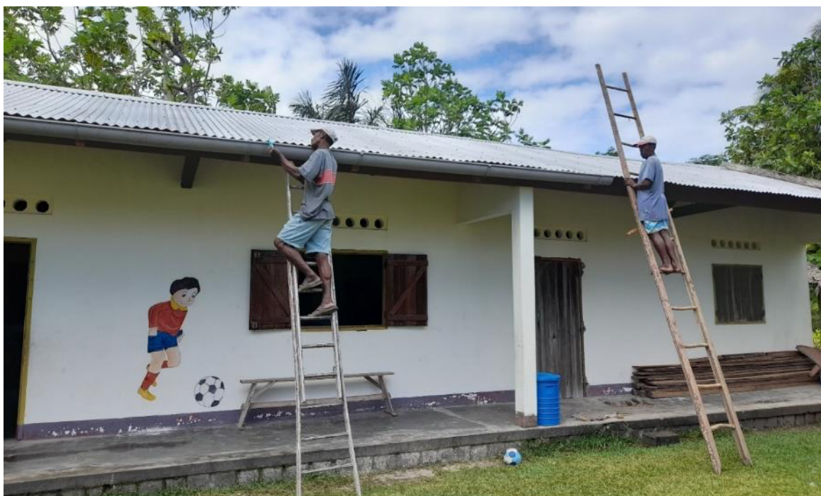
Photo 1 : Installation d'un mini-captage d'eau de pluie EP La Frégate
